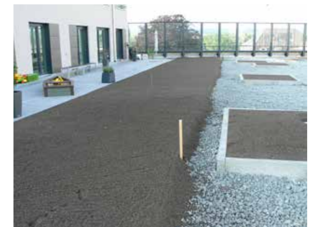
EDEKA Verbraucherzentrum a Konstanz, configurazione di vie percorribili ed aree verdi con un totale di 2'000 m 3 di MISAPOR
