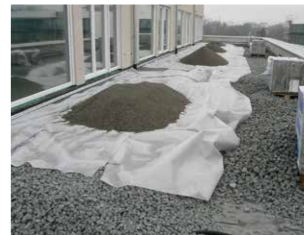
EDEKA Verbraucherzentrum Konstanz, opere di ristrutturazione con riconfigurazione dell'area sull'edificio
