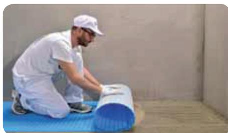
**2** Applicare electric slim membrana, precedentemente tagliata, sull'adesivo ancora fresco. Premere la membrana in modo uniforme con un rullo o con un frattazzo.
