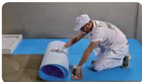
**4** Posare il telo successivo di electric slim membrana avendo cura di accostarlo al precedente senza sormontarlo e di allineare i rilievi pseudo quadrati per facilitare la posa dei cavi scaldanti.
