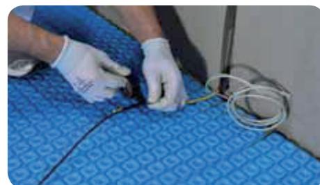
**5** Infilare il cavo freddo e i sensori di temperatura a pavimento all'interno di due differenti tubi corrugati che dalla base della parete arrivano alla scatola del termostato.
