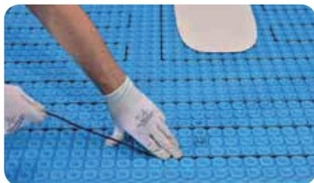
**6** Posare il cavo scaldante nella membrana con un passo pari a tre rilievi (9,3 cm). Passi più piccoli causerebbero un surriscaldamento che potrebbe danneggiare la struttura. Prestare molta attenzione a non danneggiare i cavi in particolare durante la loro installazione.
