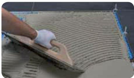
**1** Terminata la posa dei cavi scaldanti è possibile posare immediatamente le piastrelle. Con una spatola liscia riempire con un adesivo di classe C2 le cavità della membrana ed applicare lo stesso adesivo, fresco di fresco, con una spatola dentata idonea al formato delle piastrelle.
