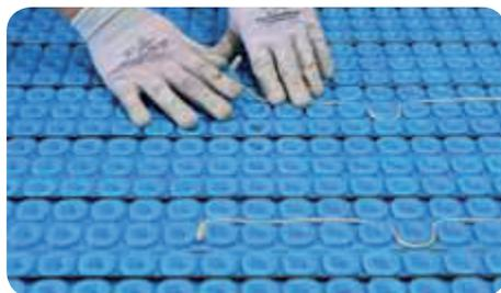
**7** Installare le sonde dei sensori di temperatura a pavimento esattamente al centro tra due cavi ed a una distanza di almeno 60 centimetri dalla parete.
