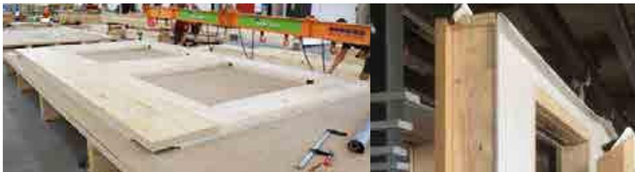
Le connessioni e i dettagli tradizionali degli architravi possono essere ottimizzati, sia dal punto di vista statico che della fisica tecnica, mediante l'impiego di STEICO LVL. Grazie ad un design intelligente possono essere realizzati architravi eleganti e snelli - cosa vantaggiosa sotto numerosi aspetti.
