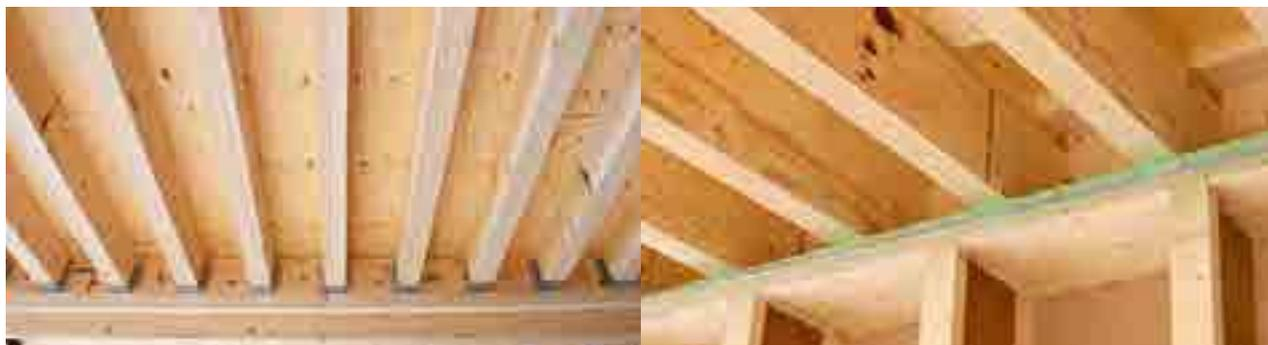
L'utilizzo di STEICO LVL R negli orizzontamenti permette di realizzare solai con campate più estese e più economiche. Grazie alle elevate proprietà meccaniche di resistenza e rigidità e alla disponibilità del materiale anche in sezioni trasversali snelle STEICO LVL R risulta particolarmente adatto all'utilizzo nella realizzazione di impalcanti orizzontali
