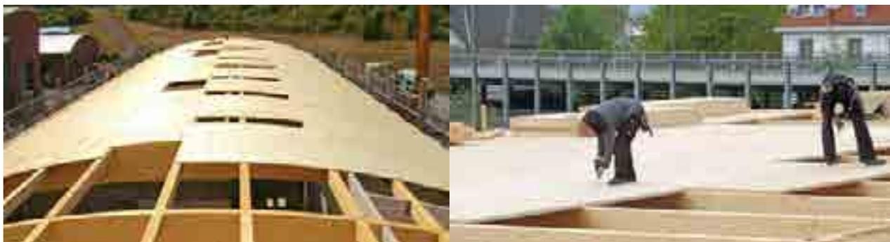
Diaframmi di piano e copertura in STEICO LVL X hanno la doppia funzione di pannello portante e diaframma controventante. Grazie a elevate rigidezze e resistenze combinate con i formati disponibili (grandi dimensioni) STEICO LVL X risulta particolarmente adatto a questo tipo di applicazione. Anche utilizzi speciali come ad esempio elementi curvilinei possono essere utilizzati conformemente alla certificazione tedesca Z-9.1-842
