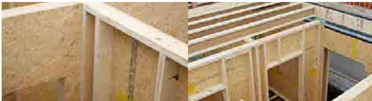
Grazie all'elevata resistenza e rigidità di STEICO LVL R è possibile ridurre le sezioni trasversali dei montanti delle pareti in strutture a telaio oppure resistere a carichi maggiori. In aggiunta a ciò i montanti di parete in STEICO LVL R sono particolarmente adatti ad essere inseriti come pilastri in caso di carichi elevati, come ad esempio in corrispondenza di finestre o in pareti interne.
