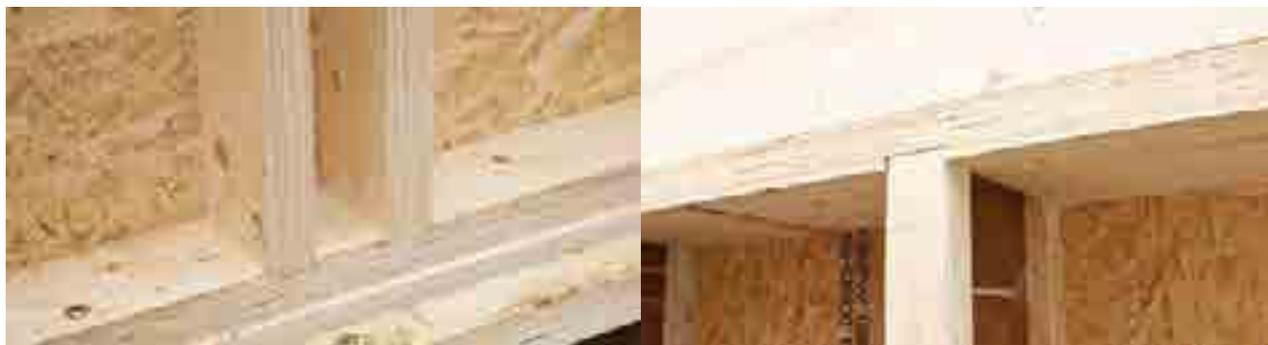
L'utilizzo di STEICO LVL per i correnti di base e travi marcapiano, consente varie ottimizzazioni nell'ambito di pareti con struttura a telaio. Grazie all'altissima resistenza a compressione, realizzando questi elementi orizzontali in STEICO LVL, si riduce la sezione dei montanti sia per pareti interne che per quelle esterne. Non solo: in pareti esterne i correnti possono essere spostati verso l'esterno anche a sbalzo oltre il cordolo in cemento.
