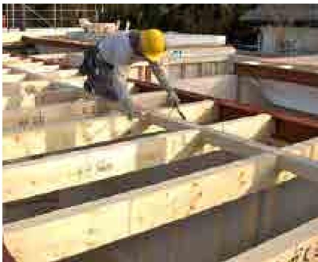
**STEICO LVL R** usato nella costruzione di strutture portanti per solai.
