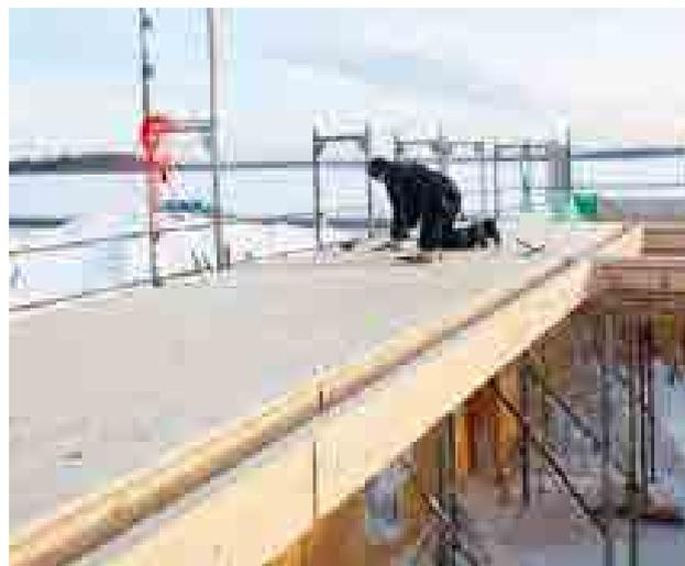
**STEICO LVL X** usato come lastra rigida nella costruzione di elementi di solaio.
