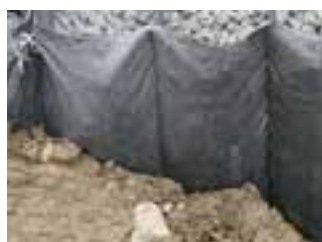
Isolamento perimetrale verticale
