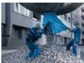
Isolamento perimetrale orizzontale
